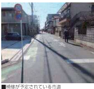
補修が予定されている市道
